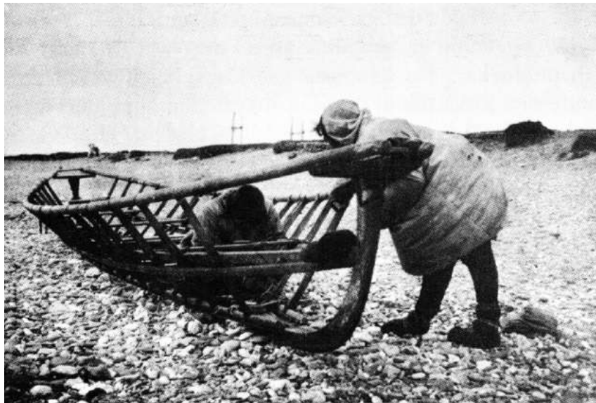
Két Chukchi férfi Bering Strait (Kelet-Szibéria) településen egy bőrral bevonandó kajakot készít. Forrás: Pálsi 1917-1919.
